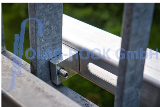
Abb. 8b/Spezialklemme an eckigem Geländerstab
