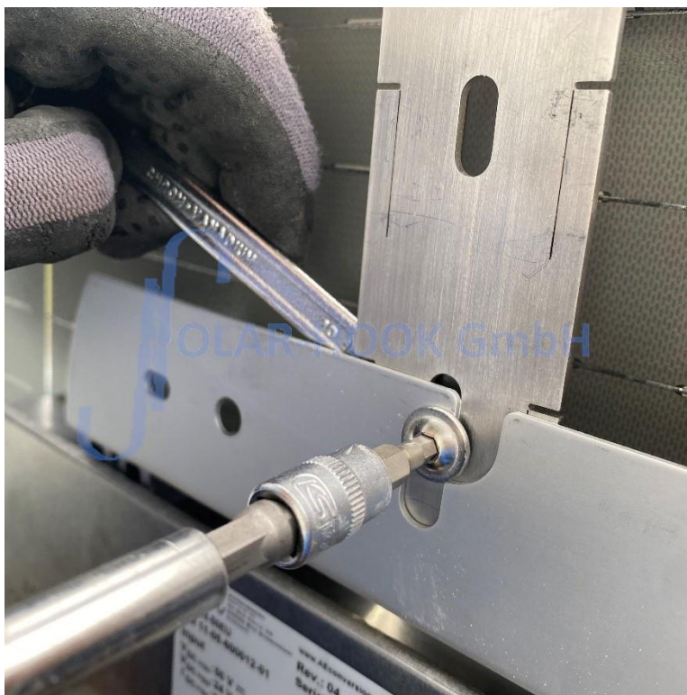
Abb. 6/Wechselrichter am SOLAR-HOOK Befestigungsbügel anschrauben
