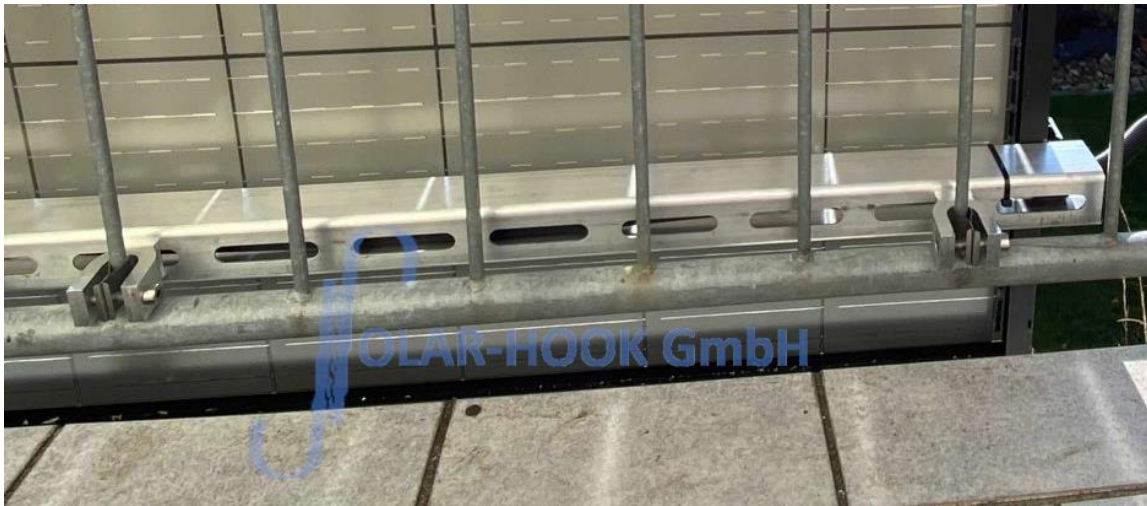
Abb. 10/ Montageschiene an Spezialklemme
