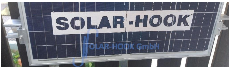
Abb. 12/Modulendklemme anbringen rechts und links
