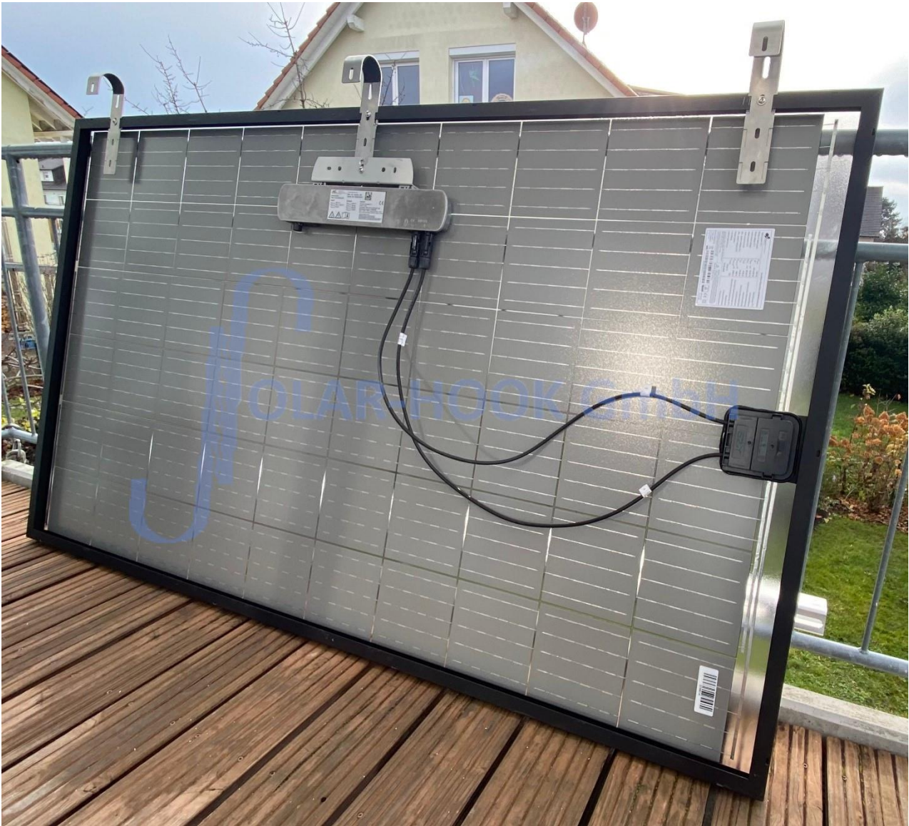
Abb.7/vorbereitetes Solarmodul mit 3 Befestigungsbügeln und Wechselrichter
