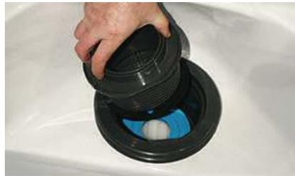
**Schritt 2.** Entfernen Sie den Korb
