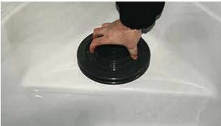
**Schritt 1.** Um den Korb herauszuheben, drehen Sie die Vorrichtung gegen den Uhrzeigersinn, bis Sie ihn
