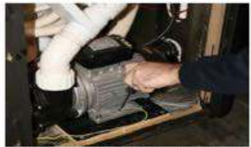
Ausbau der elektronischen Teile, Pumpen etc.; Trocknen und warm lagern
